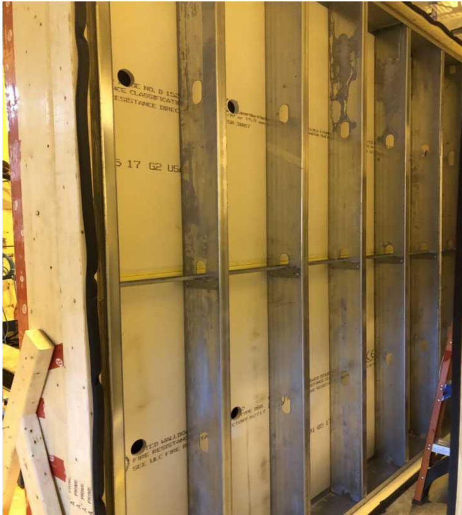
Photo 3 - Section du mur (montants)
